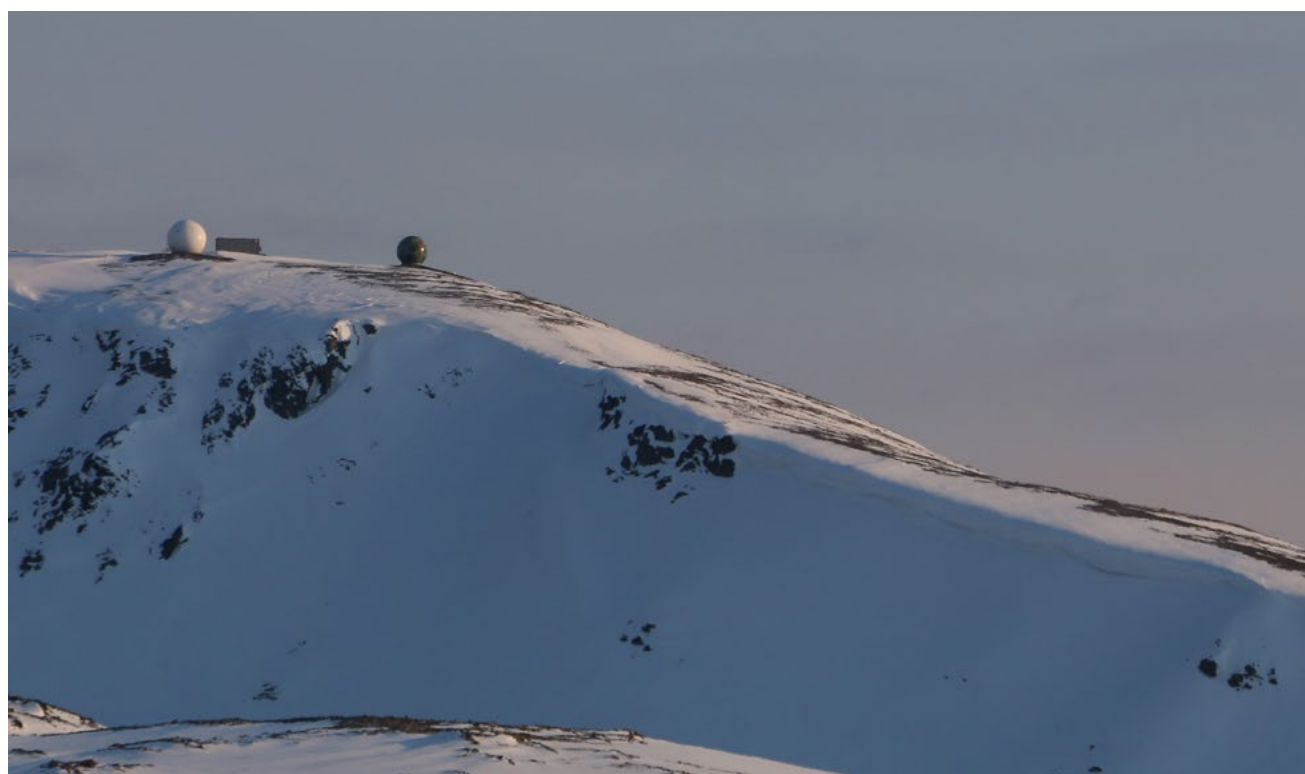
↑ Kystverkets antenner i Vardø. Antennene brukes til kommunikasjon med AIS-satellittene. Foto: Statsat.
